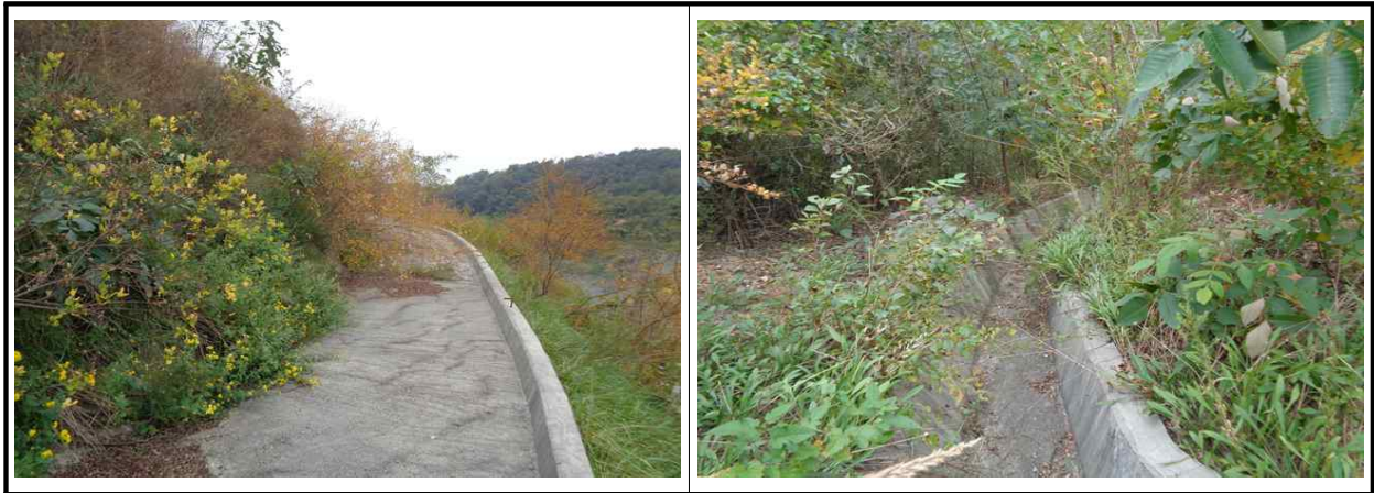
【그림 4.3.3】 배수시설 전경
